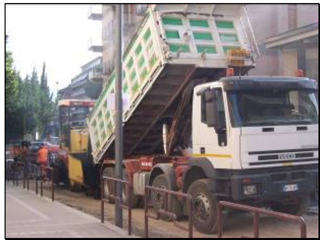
Figura 12 Il dumper, proveniente dall'impianto di produzione del bitume, ricarica la finitrice in breve tempo grazie al sollevamento del suo carico.
