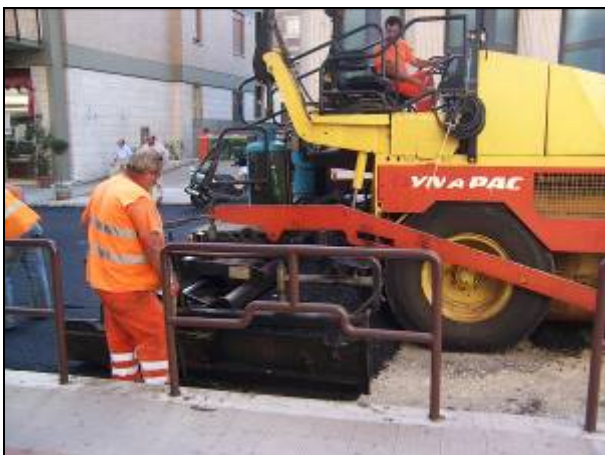
Figura 13 L'operatore aziona i comandi per regolare al meglio la larghezza di stesa e accompagna la finitrice nel suo moto.
