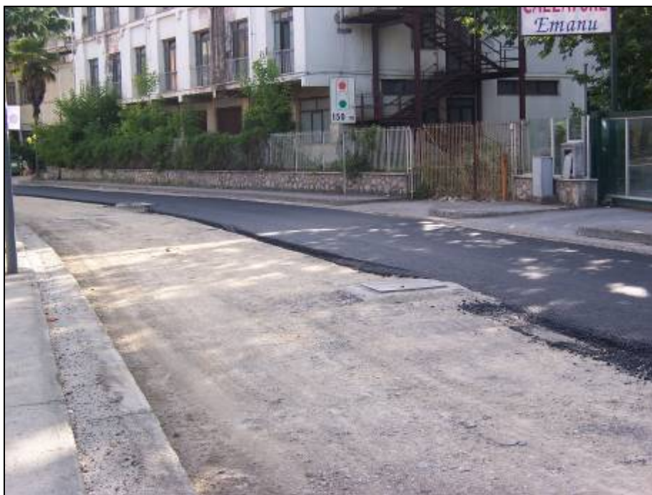
Figura 15 L'immagine mostra il primo strato di base che poggia direttamente sulla fondazione.
