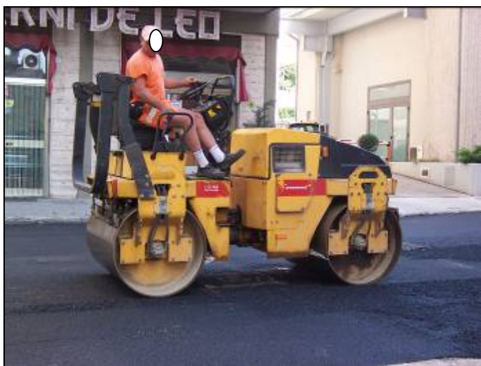
Figura 22 Il mezzo passa più volte sul conglomerato caldo, anche in prossimità dei tombini dove è conveniente rallentare la sua velocità.
