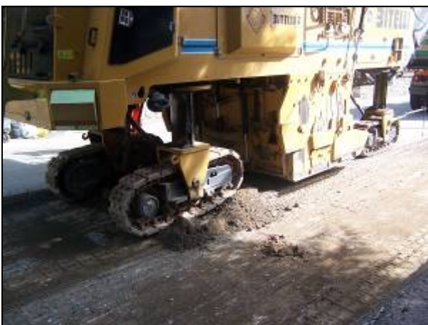
Figura 9 La macchina demolitrice viene fermata per superare i tombini che non vengono perciò interessati nella demolizione.
