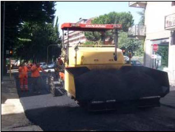
Figura 16 Il secondo giorno di lavori comincia con la stesura del secondo strato, in maniera analoga quanto fatto per il primo strato.
