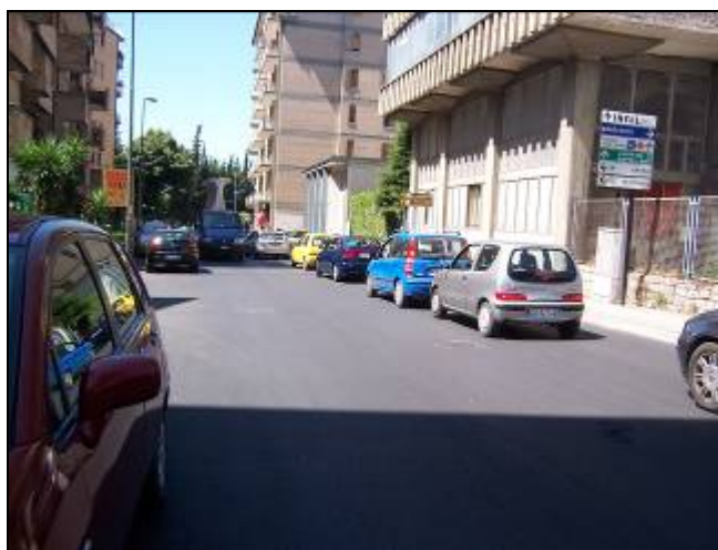
Figura 2 Immagine dello stato attuale della strada.
