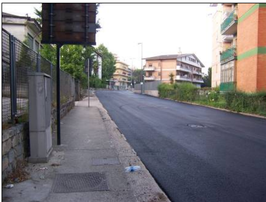
Figura 24 L'ultima immagine è dedicata al risultato finale dei lavori, è da notare il classico colore scuro del conglomerato bituminoso nuovo che, però non durerà a lungo.
