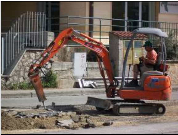
Figura 7 Particolare attenzione deve essere posta nella demolizione in prossimità dei tombini dove sono presenti parti di impianti di scarico delle acque piovane e nere che potrebbero subire dei danni.
