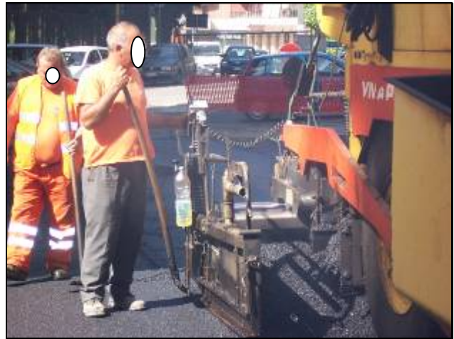
Figura 19 L'ultimo strato è quello con la quantità maggiore di legante e con la massima compattezza.
