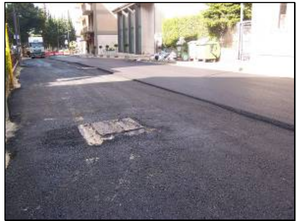
Figura 17 Il confronto fra i due strati è evidente, le caratteristiche dei conglomerati sono differenti, il primo strato usa pezzature maggiori.
