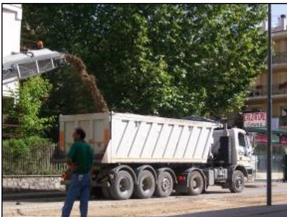
Figura 5 Il dumper riceve i frammenti della vecchia pavimentazione e quando è ormai colmo, parte verso la zona di scarico.
