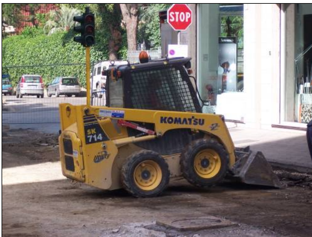
Figura 10 L'operatore della macchina provvede a demolire in maniera più accurata i bordi della strada, in prossimità dei marciapiedi, e convoglia il materiale indesiderato ai bordi.
