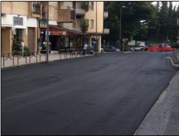
Figura 18 Il risultato finale della stesura dell'ultimo strato.
