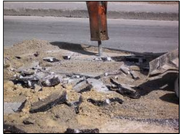
Figura 8 In prossimità dei tombini, molto frequenti nella strada in oggetto, il martello pneumatico consente una accurata demolizione che non danneggia parti importanti come i pozzetti in cls.
