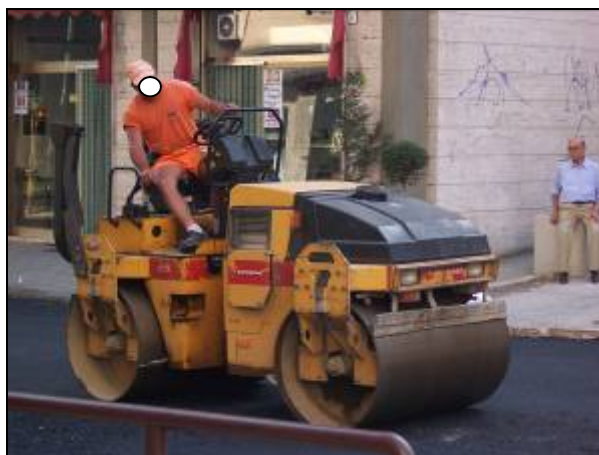
Figura 14 Il rullo segue la finitrice subito dopo per compattare al meglio il materiale.
