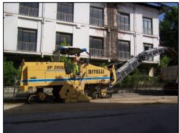
Figura 5 La demolitrice asporta la vecchia pavimentazione e, grazie a un nastro trasportatore convoglia il materiale in quota.
