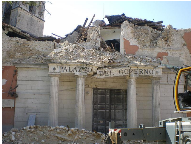
Collasso della Prefettura de L'Aquila dopo il terremoto del 2009, M 5,9.
